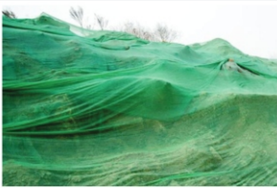
खड़ी निर्माण सामग्री का उचित आवरण
